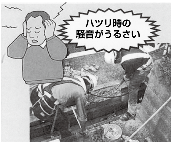
従来工法である電動ハンマーによるハツリ作業
