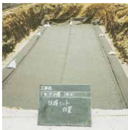
2 保護シート敷設
