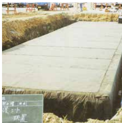
7 遮水シート、保護シート敷設完了
